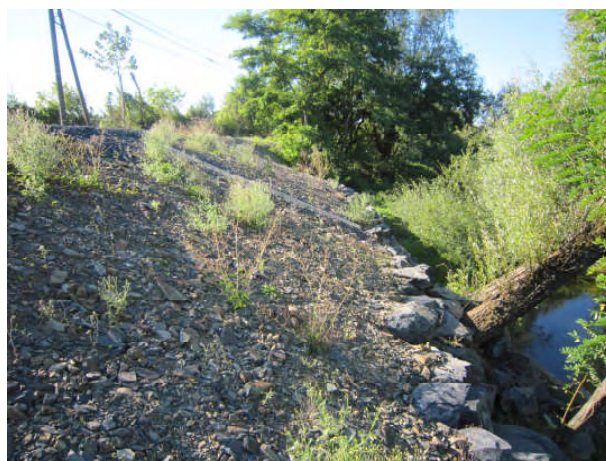
d : enrochement le long de l'Arroux
