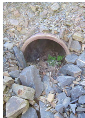
e : tuyau au niveau de l'enrochement
