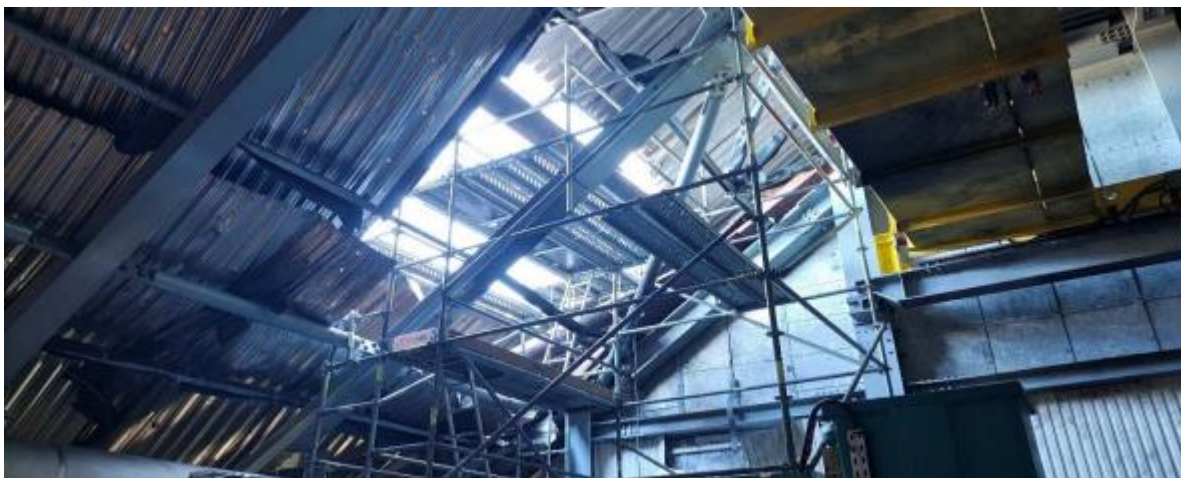
Figure 5 : Mise en place d'un échafaudage dans la zone d'impact 10
