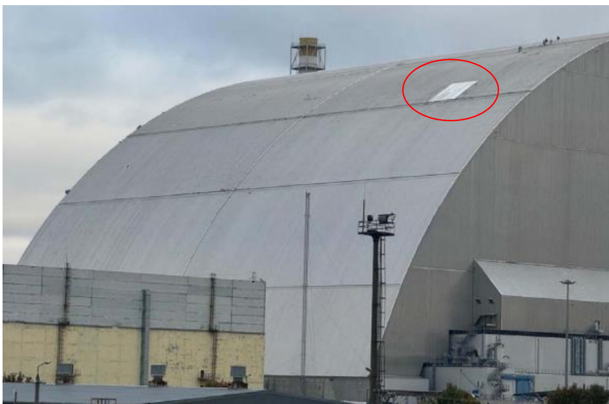
Figure 6 : Réparation de la structure externe de l'arche de confinement (NSC), octobre 2025 [9]
