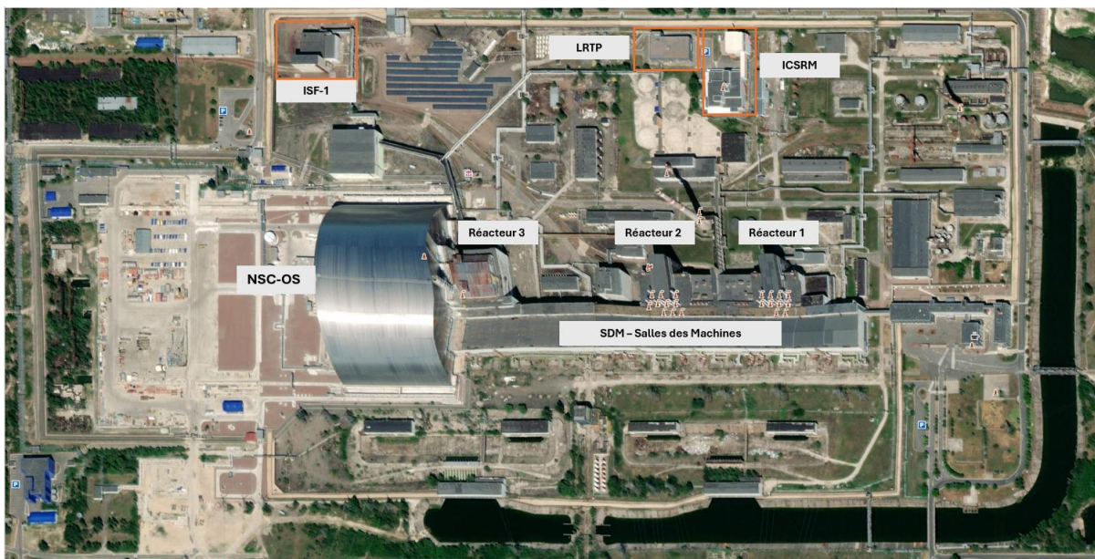
Figure 8 : Centrale de Tchernobyl
