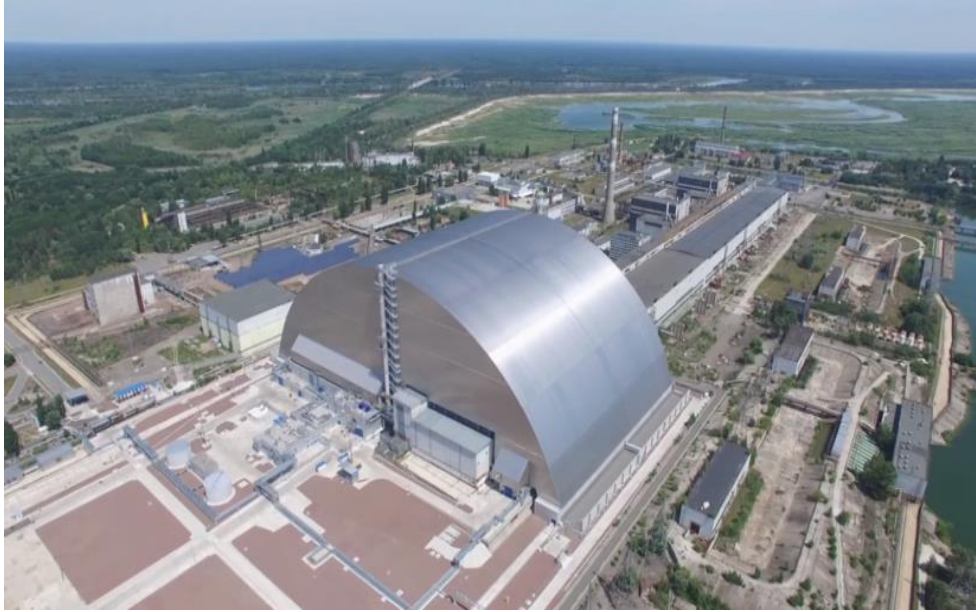
Figure 1 : Le Nouveau Confinement Sûr (NCS) du réacteur accidenté n°4 (source ChNPP: Viktor Kuchynskyi)
