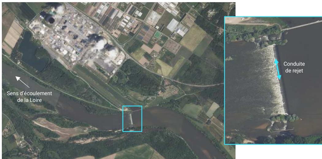
Figure 8 : Visualisation satellite de l'ouvrage de rejet en Loire du CNPE de Dampierre-en-Burly
