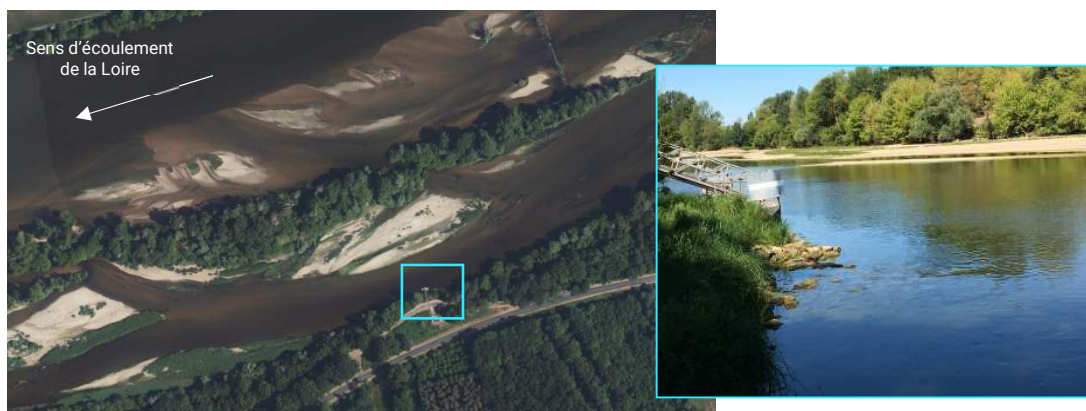
Figure 18 : SMP aval du CNPE de Chinon
