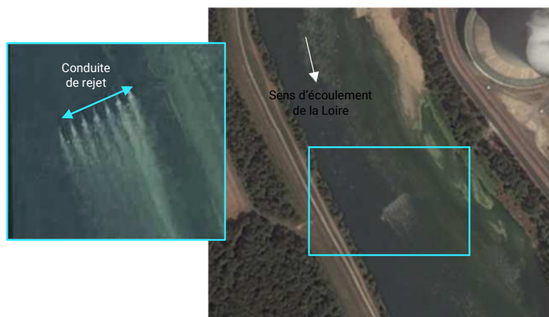
Figure 12 : Visualisation satellite de l'ouvrage de rejet du CNPE de Saint-Laurent-des-Eaux
