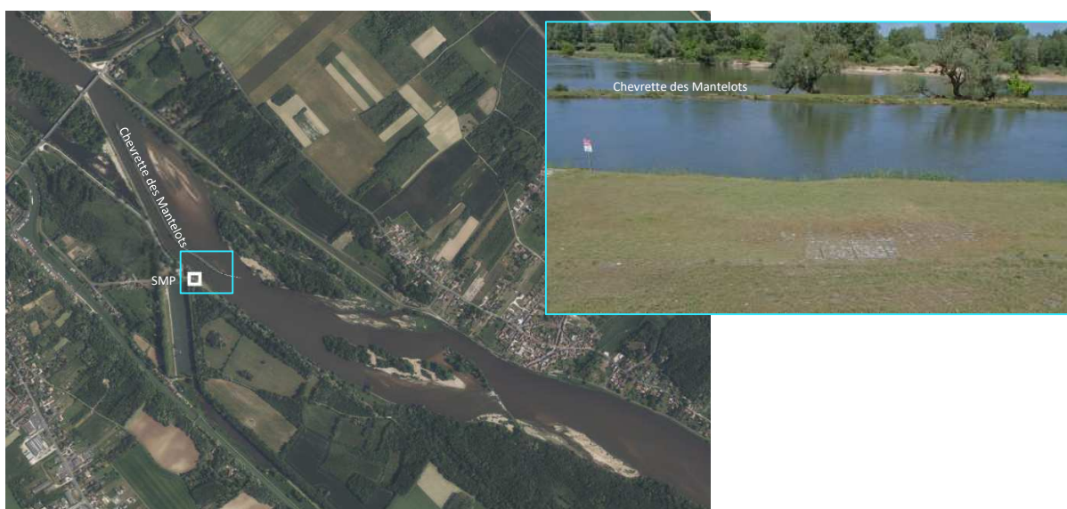
Figure 5 : SMP aval du CNPE de Belleville-sur-Loire au sein de l'écluse des Mantelots
