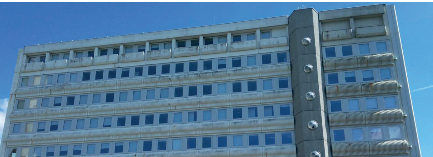
Bâtiment Triangle (Fontenay-aux-Roses) : un chantier à 531 fenêtres
