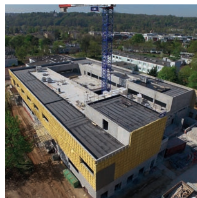
Le bâtiment Z en construction (Le Vésinet)
