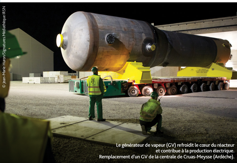
Les parois des tubes des générateurs de vapeur font 1 mm d'épaisseur. Les échanges thermiques nécessaires à la production de l'électricité sont ainsi très performants. C'est aussi un facteur de fragilité, très surveillé.
