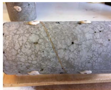
La réaction sulfatique interne est une dégradation du béton pouvant toucher l'enceinte de confinement.
