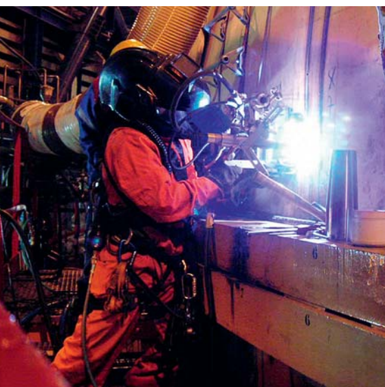
Centrale de Creys-Malville (Isère) : découpe à la torche à plasma réalisée par une entreprise sous-traitante.
