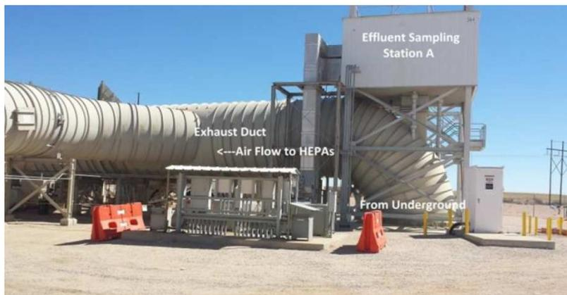
Figure 23 : Schéma et photographie du système de ventilation du WIPP, au niveau du puits d'extraction d'air (DOE, [27] [28])
