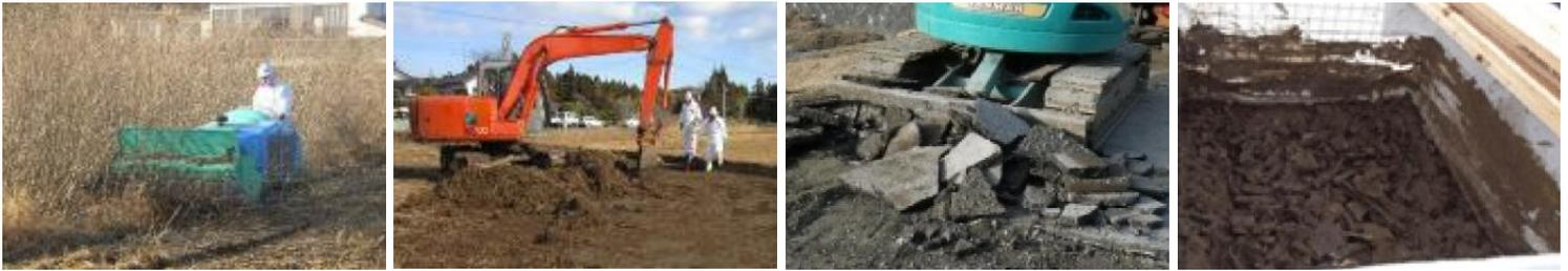
**Figure 8 : Photographies de déchets générés par des actions de réduction de la contamination dans la préfecture de Fukushima. De gauche à droite : taille, retrait d'une couche de sol, retrait d'un revêtement de route, boues séchées après traitement [55].**
