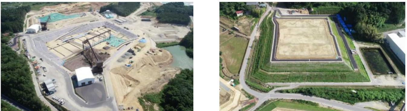
Figure 15 : Installation d'entreposage des terres contaminées, en cours de remplissage (à gauche) et après remplissage (à droite) [108].
