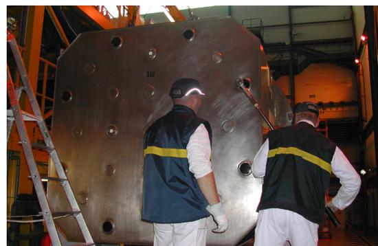
**Figure 2.14** / Opération de serrage des vis de capots amortisseurs.
