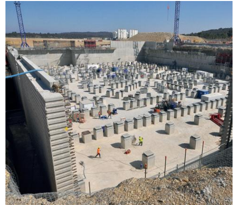
Construction des appuis parasismiques du complexe Tokamak de l'installation ITER (avril 2012)
