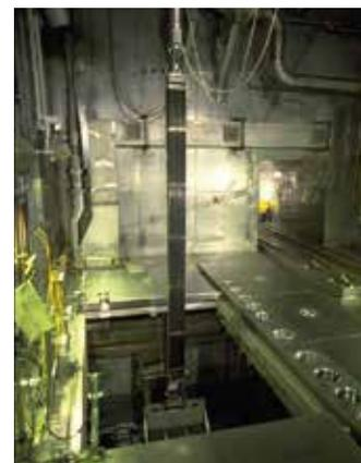
Figure 2.36 Descente d'un assemblage combustible dans le puits de refroidissement de l'atelier T0 de l'usine AREVA NC de La Hague.
