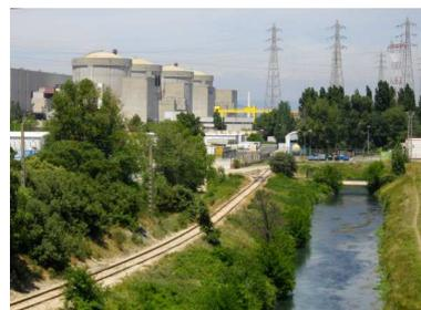
EURODIF était une usine de séparation des isotopes de l'uranium par diffusion gazeuse, en vue de la fabrication du combustible pour les réacteurs.
