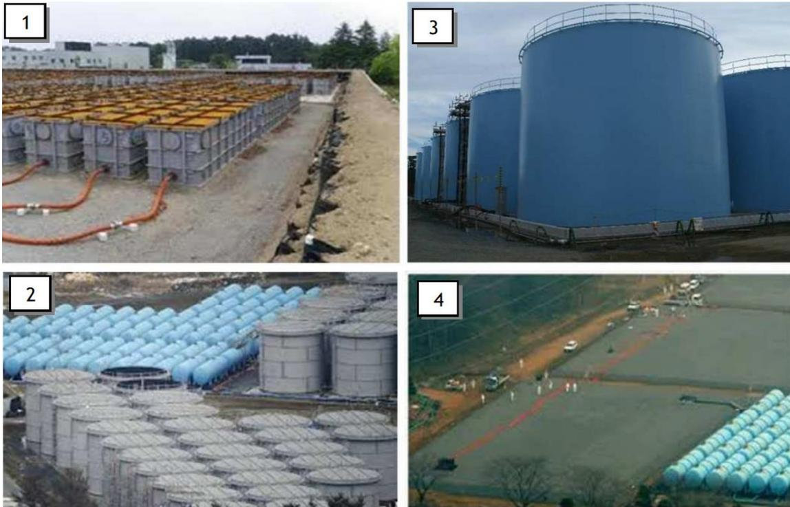
Source TEPCO - 1/réservoirs cubiques soudés - 2/réservoirs verticaux à assemblages par brides boulonnées et réservoirs horizontaux soudés - 3/réservoirs verticaux soudés - 4/réservoirs enterrés
