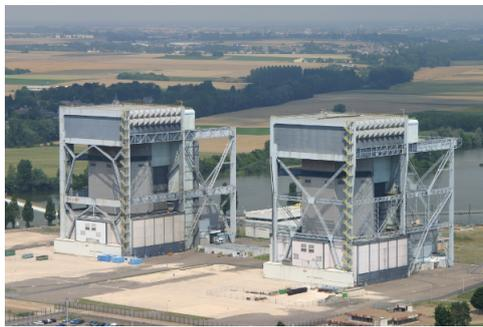
FIGURE 1.2 – Réacteur modéré au graphite en attente de démantèlement
