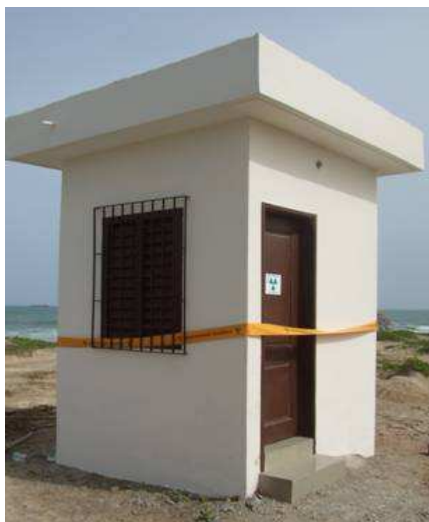
Local d'entreposage dans la zone portuaire
