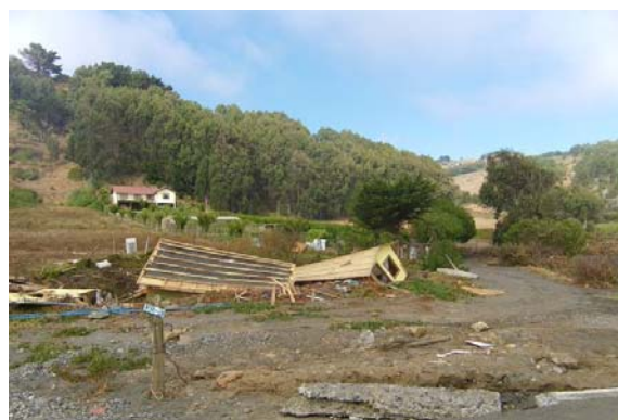
Figure 8: Le tsunami a déplacé des maisons en bois sur plusieurs dizaines, voire centaines de mètres. En haut, à Tirua, même si la hauteur de la vague n'a pas été très importante (~5 mètres), l'inondation s'est avancée très loin dans l'estuaire. A Lipimavida (en bas), le déferlement de 8 m a déplacé plusieurs maisons à quelques dizaines de mètres au-dessus de la plage.
