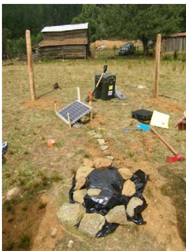
Figure 5 : Installation lors de la mission LIA d'un sismomètre et d'un panneau solaire (gauche). Accéléromètre implanté sur une dalle préfabriquée (haut)
