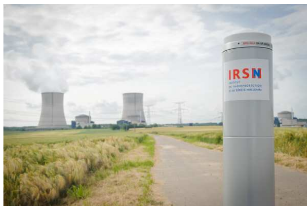
Balise mobile Téléray installée devant la centrale de Cattenom
